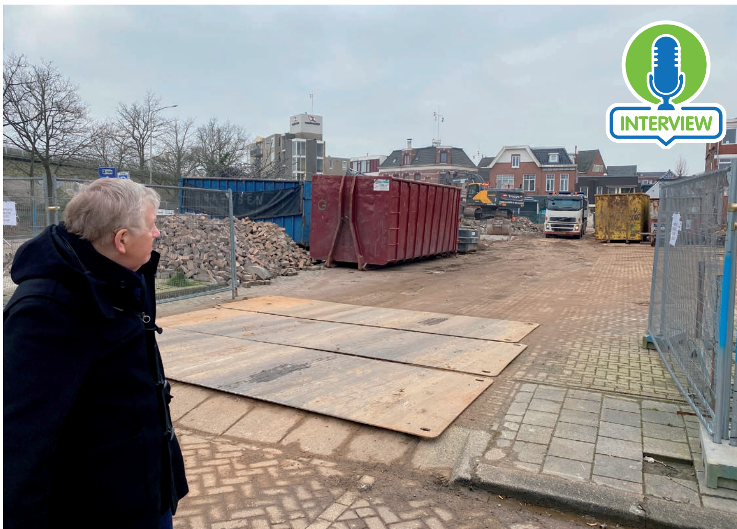
Joop overziet het bouwterrein
