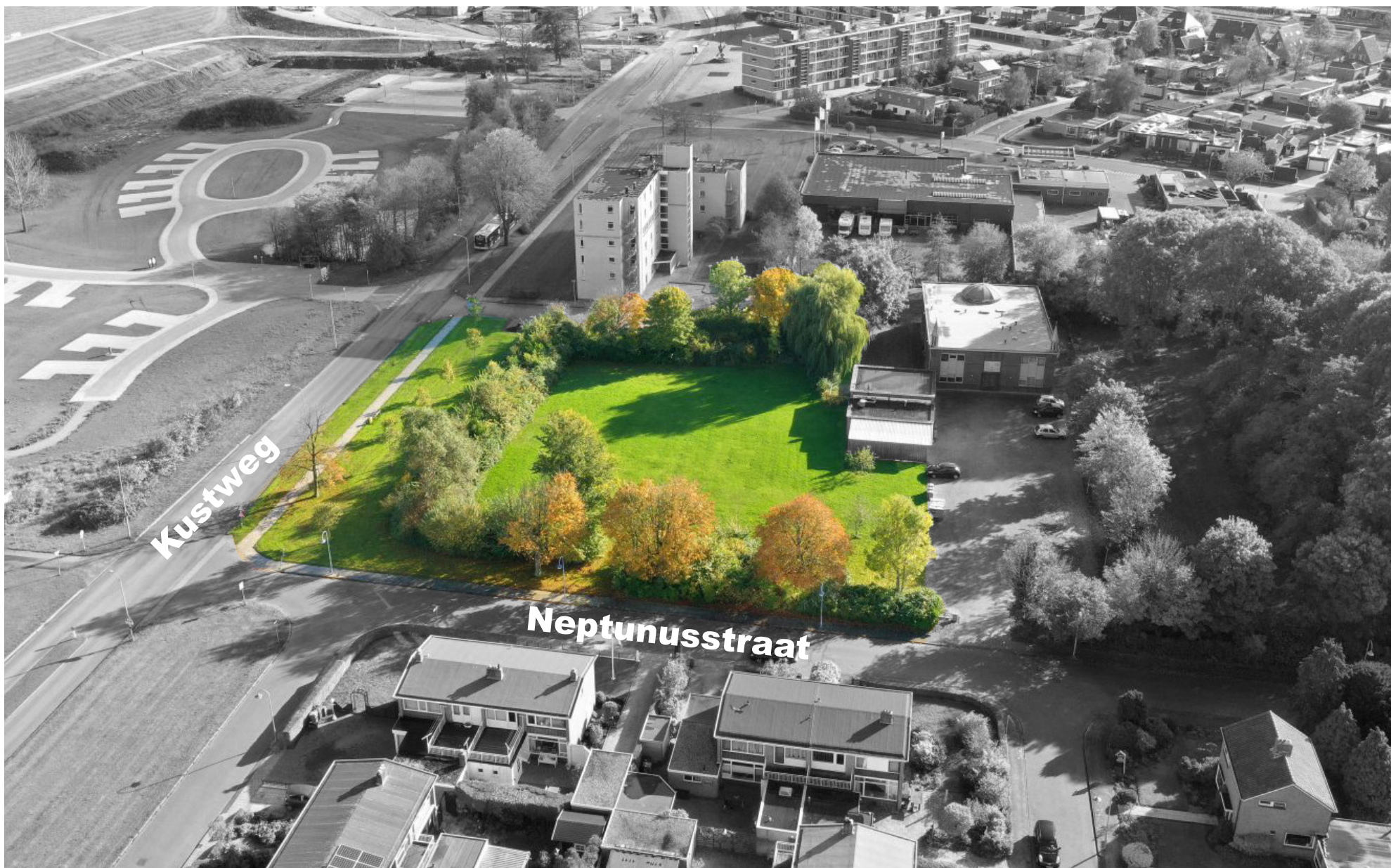
Luchtfoto projectlocatie gelegen aan de Kustweg met uitzicht richting de dijk.
